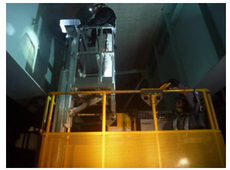
橋梁点検昇降装置の開発
