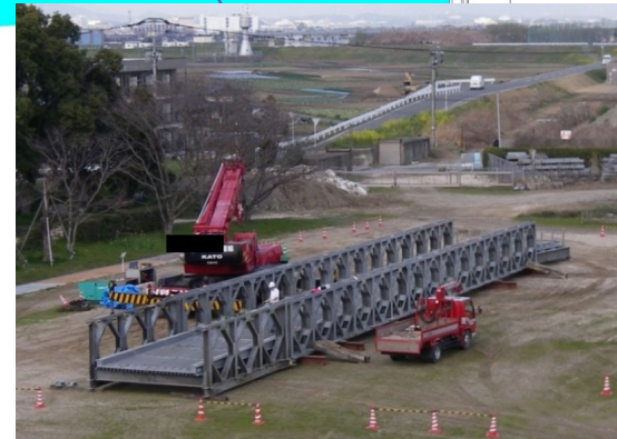
【応急組立橋】 災害時に落橋した橋の代替として使用
