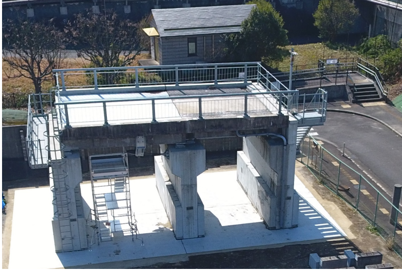
『橋梁モデル』 実際に使用していた橋を活用
