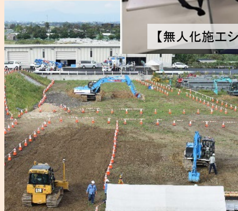
【ICT建機・無人化施工操作体験】
