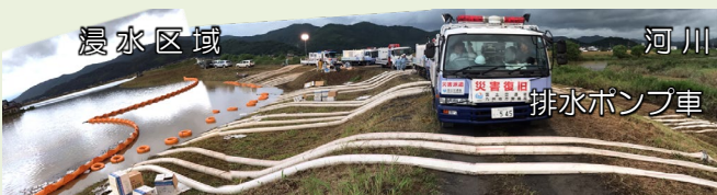
【浸水区域の緊急排水作業(R1.9 佐賀県大町町)】
