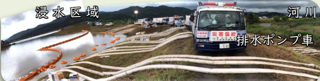
【浸水区域の緊急排水作業（R1.9 佐賀県大町町）】
