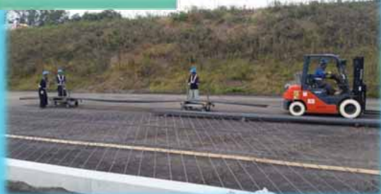
配力筋D13設置状況
