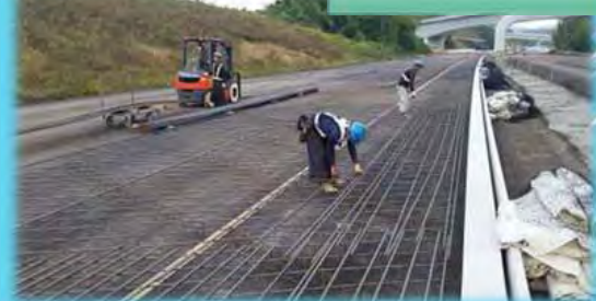
主筋D16設置状況
