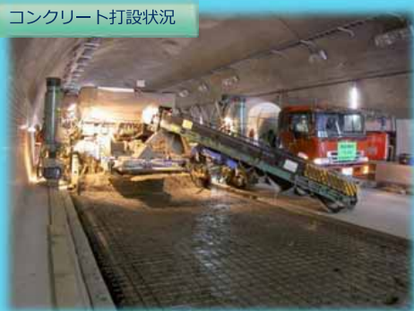
コンクリート打設状況
