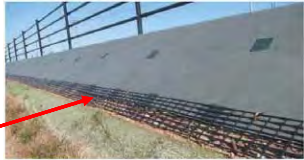
施工イメージ
