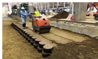
テラグリッド工法の転圧状況
