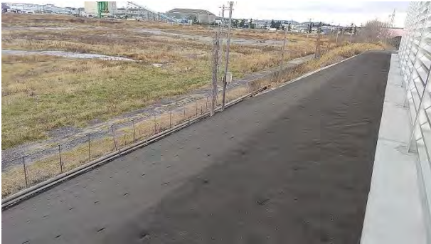
民間 造成のり面
