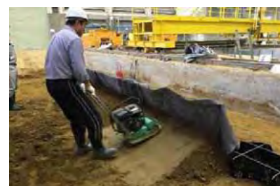
鋼製枠壁面材裏の転圧状況
