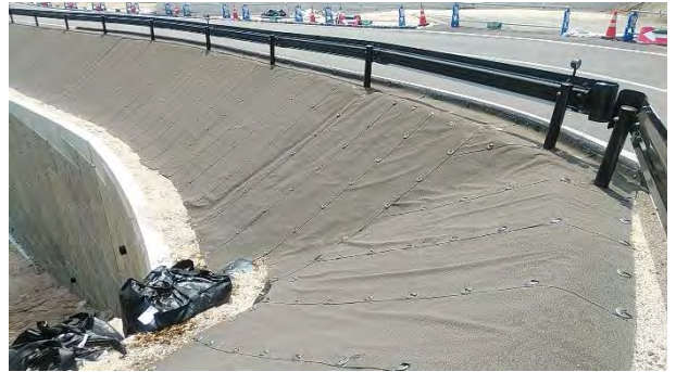
県道 道路下のり面
