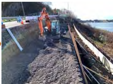
手順②: 盛土材撒き出し・転圧
