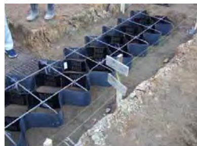
手順①: グランドセルの展開・設置
