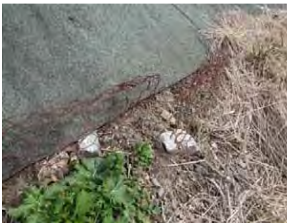
金網では耐候性に劣り、捲れが生じる
