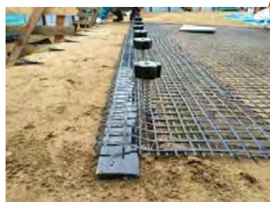
手順④: 縦材・接続材設置
