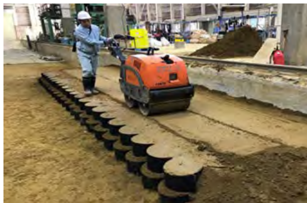
写真-1 ジオセル内外の確実な締固め
