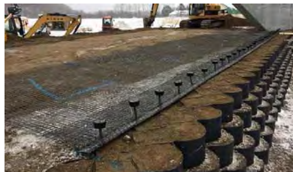
施工中の接続部の状態
