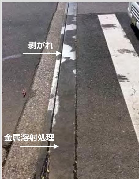
金属溶射表面処理の剥がれ
