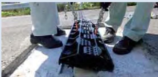
ボルト・ナット構造により本体のみ取替可
