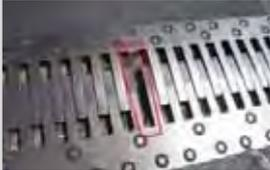
繰返し車両通行による疲労破壊
