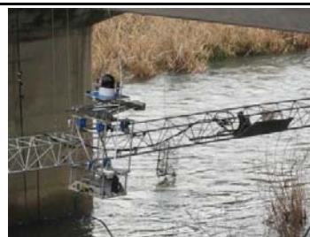
水平材を移動するゴンドラ
