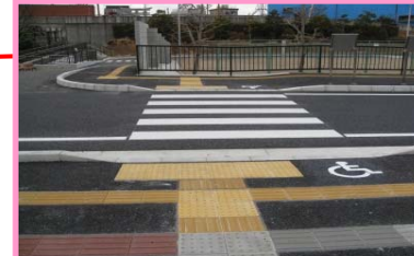
② 横断歩道乗入縁石段差
