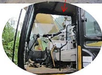
ロボQによる災害復旧作業 (H24. 6 鹿児島県垂水)
