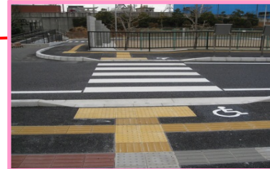
②横断歩道乗入縁石段差
