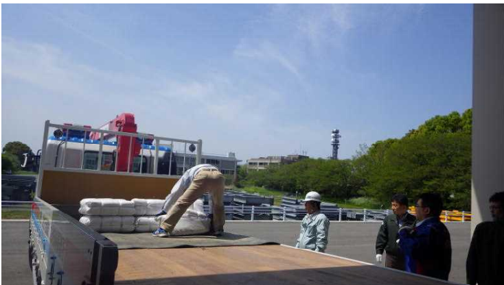
小型土のう（約3,000袋）積込作業状況（九州技術事務所 4月15日午前10:30頃）
