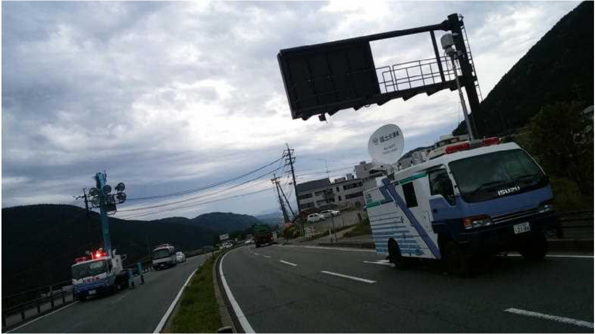
▲南阿蘇村立野国道 57 号法面崩壊対応として照明車、待機支援車を配備
