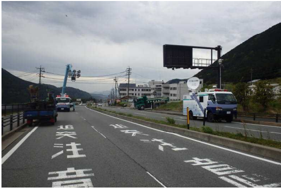
▲国道 57 号対応状況（熊本県大津町） （衛星通信車・照明車）
