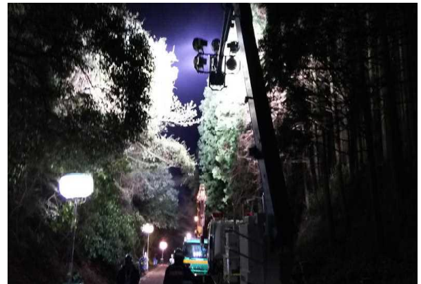
▲現地災害対応状況（照明車）
