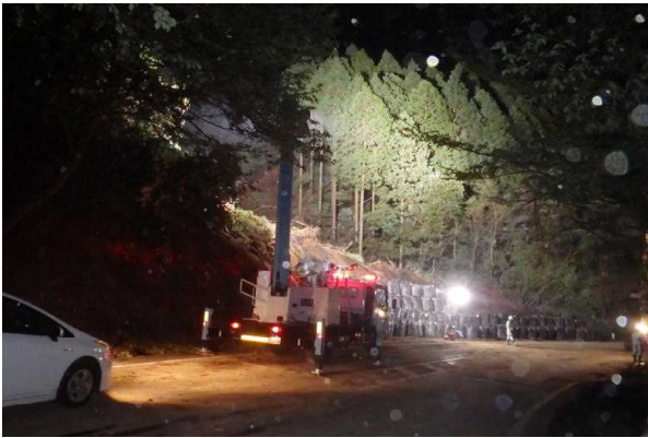
▲現地災害対応状況（照明車）
