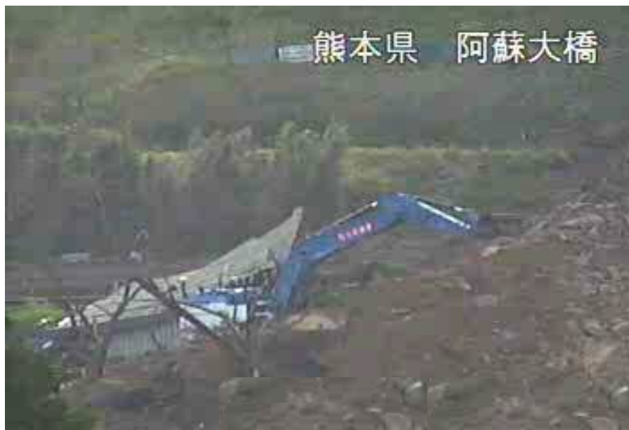
▲ 国道57号（南阿蘇町立野地区）崩落箇所土砂撤去中 （遠隔操縦バックホウ 稼働中）
