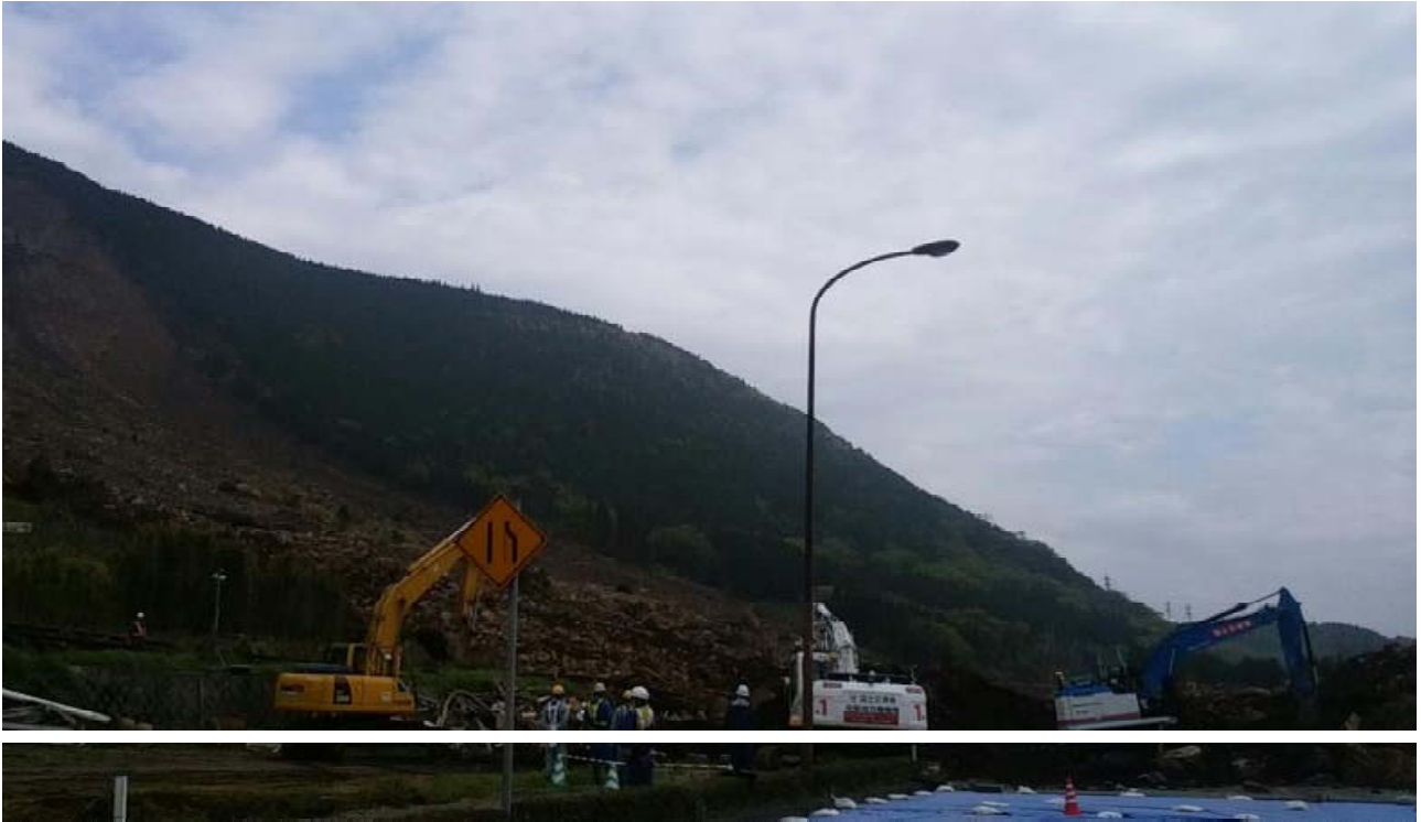
復旧活動中の無人化施工機械。 4月23日午前8時50分頃 南阿蘇村立野地区の国道57号にて熊本側より大分方面を望む 九州技術事務所 TEC-FORCE 隊撮影。
