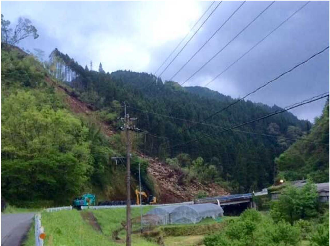
▲ 被災箇所の全景
