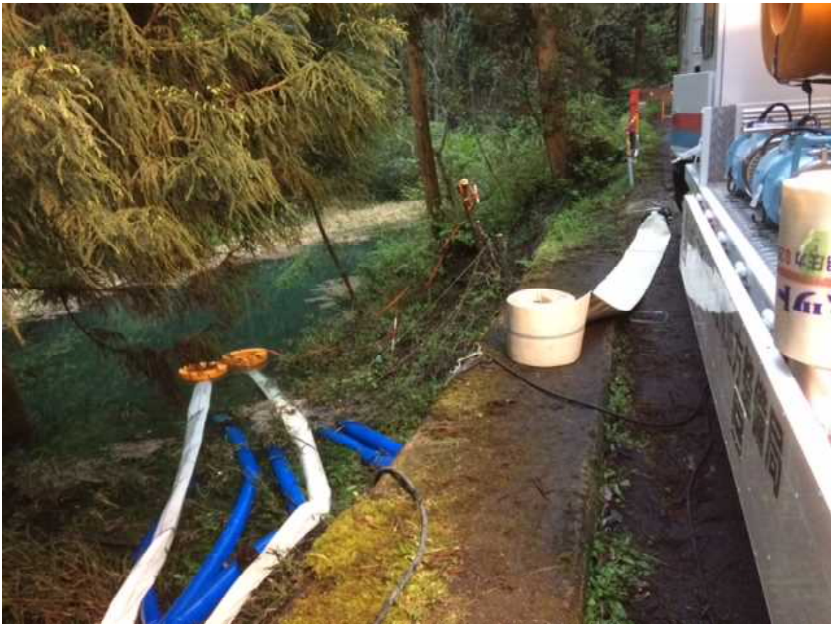
▲ 排水ポンプ車(排水能力30m 3 /min)による排水作業中
