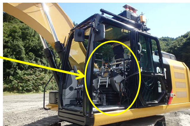
遠隔操縦装置の設置状況
