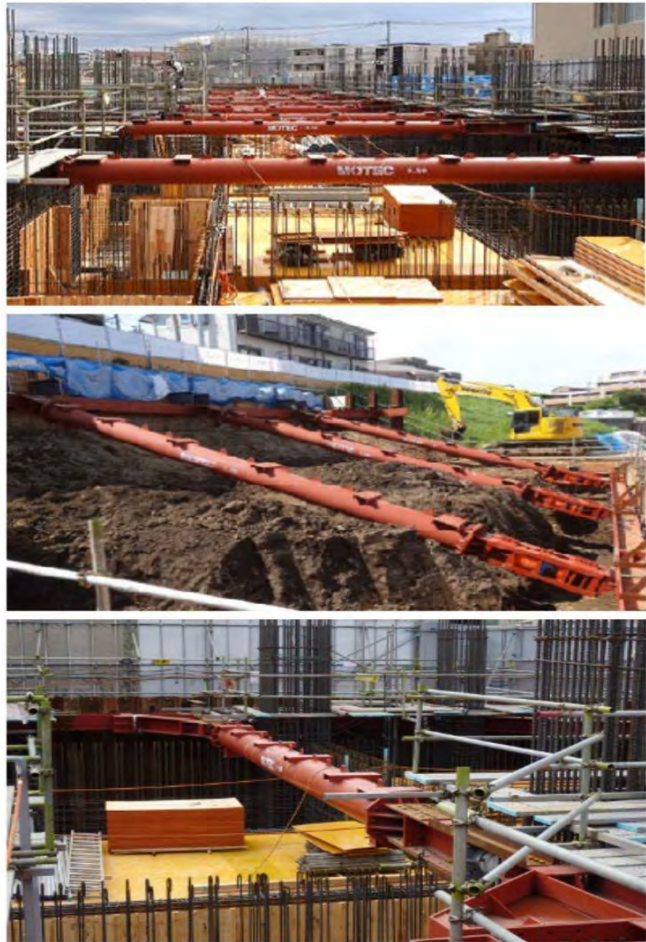
円形鋼管切梁「Circular Strut」設置例
