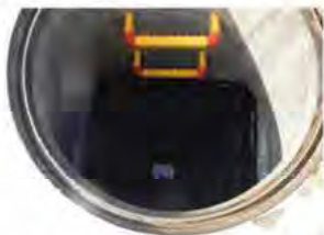
ハイドロスタッフ上部の点検人孔部
