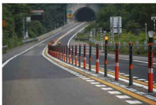
東日本高速道路株式会社 秋田自動車道
