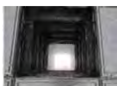
点検孔上からののぞき写真
