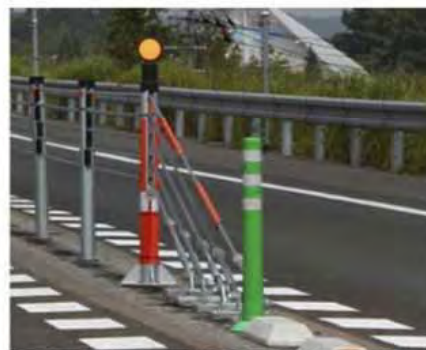
国土交通省 北海道開発局 深川留萌自動車道
