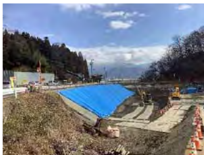
道路拡幅盛土
