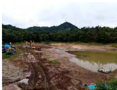
ため池放射性汚染土撤去
