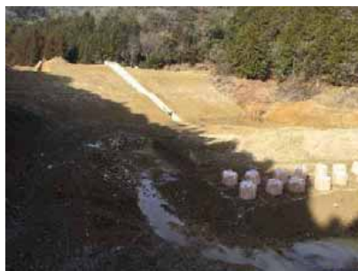
ため池堤体改良
