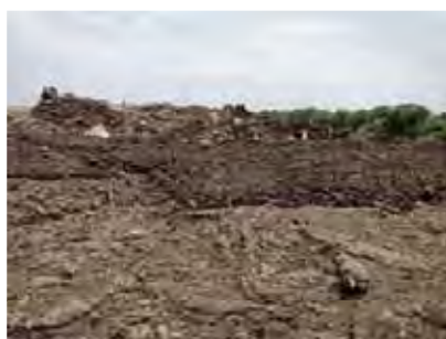
豪雨災害崩落土砂処理
