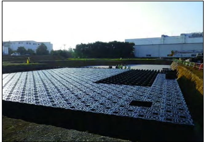
写真-2 ハイドロスタッフ 施工写真
