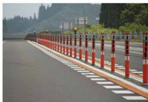
東日本高速道路株式会社 秋田自動車道
