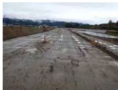
河川堤防 (浚渫土を利用)
