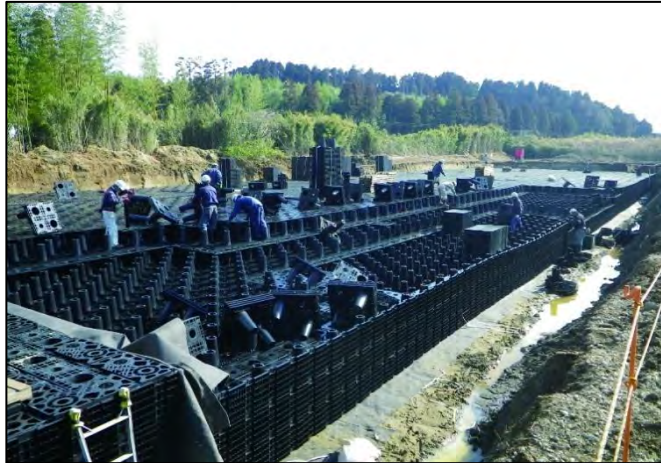
写真-1 ハイドロスタッフ 施工写真
