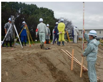
■ 丁張実習 測量ミスは構造物の作り直しにつながります。正確な測量を！
