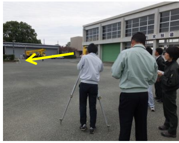
■ 測量実習（TS） 水平角、距離等を観測手簿に記録
