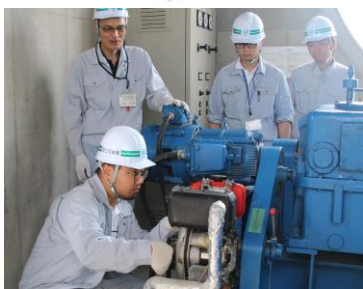
■ 実物水門の操作実習 手動での駆動がけ
