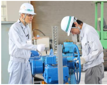
■ 小型水門の操作実習 水門の機能と構造
