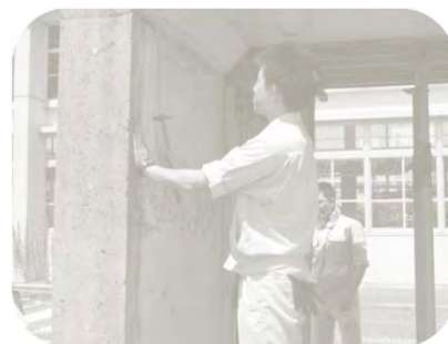
点検ハンマーを用いた打音調査
