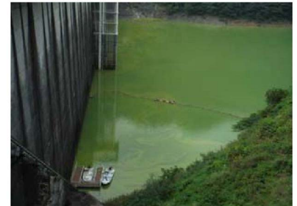
③サイドより堤体沿いを望む
