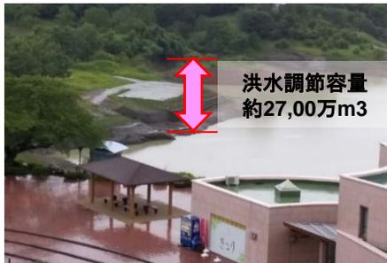
通常よりも水位を約3m低下させ、300万m3の容量を増強し、計2,700万m3の容量（ヤフオクドーム約15杯分）を確保し洪水に備えました。
