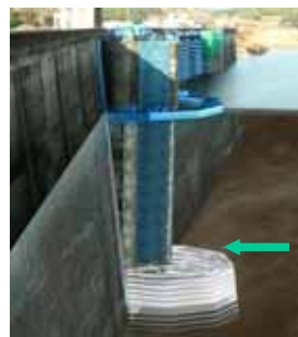
選択取水設備未使用時
