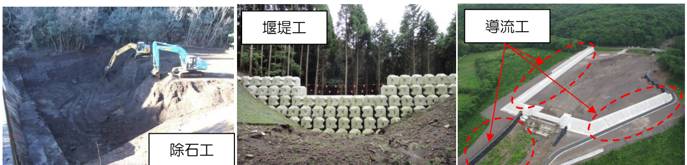
図 11 平成 23 年新燃岳噴火後に実施された対策工例
