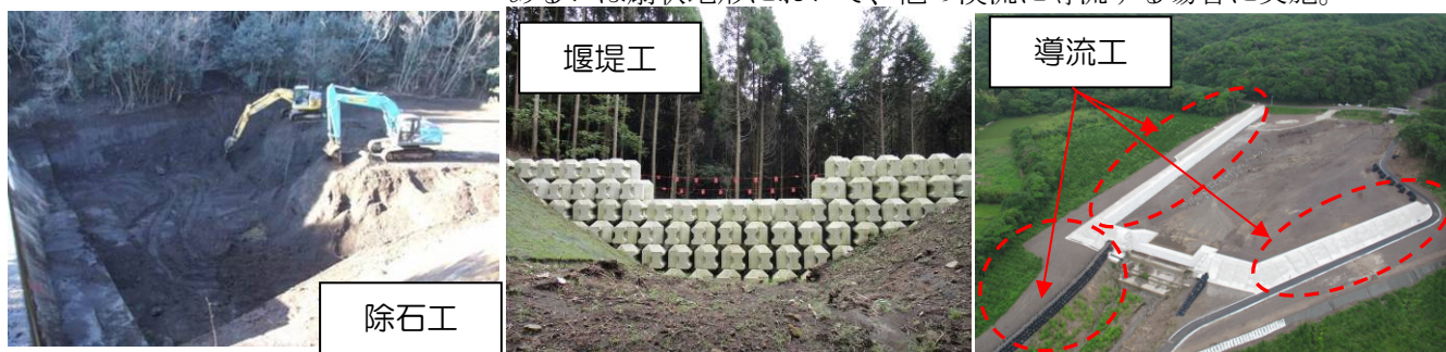
図 11 平成 23 年新燃岳噴火後に実施された対策工例
