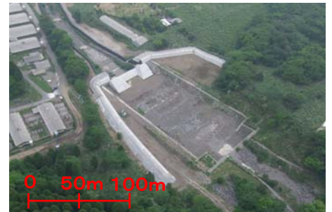
荒川内川の緊急氾濫防止対策工事
