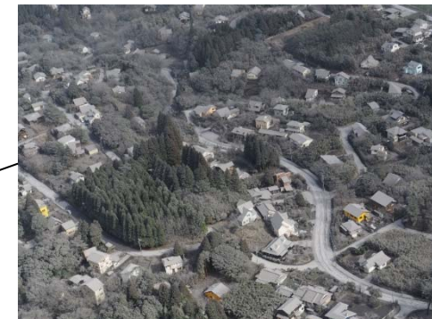
宮崎県都城市付近の状況 (平成30年3月6日ヘリ調査)
