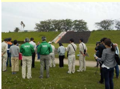
危険箇所合同調査実施状況
