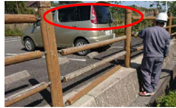
転落防止策の破損
