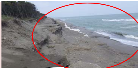
養浜はほぼ流出しましたが、サンドバックにより浜崖は守られています。
