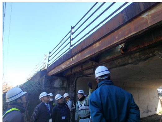
▲1月25日(木) 都城地区 国道10号溝橋 1市 4名
