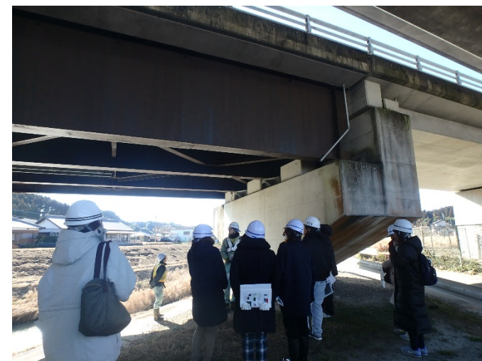
▲1月24日(水) 宮崎地区 国道10号生目高架橋 1町1機関 11名
