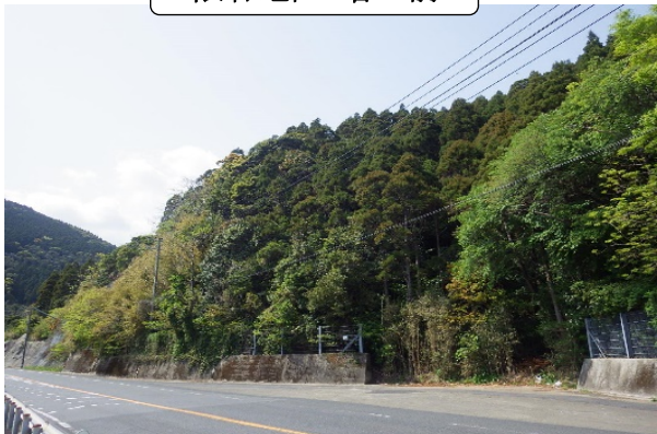
隈谷地区 着工前
