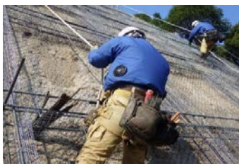
法枠工施工
