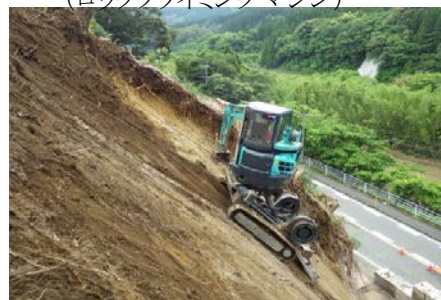
榎原地区掘削状況 (ロッククライミングマシン)
