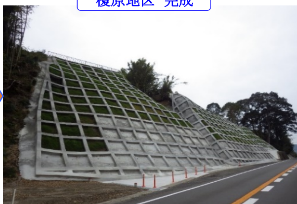
法枠工施工
