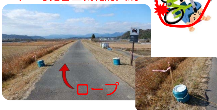
■十日町樋管上流堤防天端
