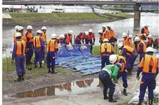
本市消防団⑧: シート張り工
