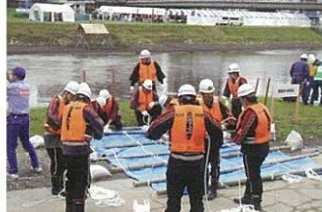
宇土市消防団: シート張り工
