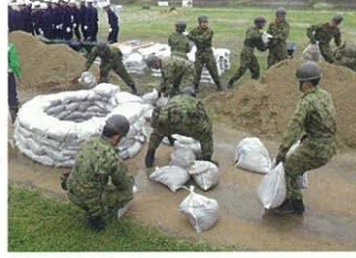
陸上自衛隊第42即応機動連隊: 釜段工
