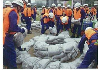
熊本市消防団④: 釜段工
