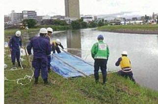
嘉島町消防団: シート張り工
