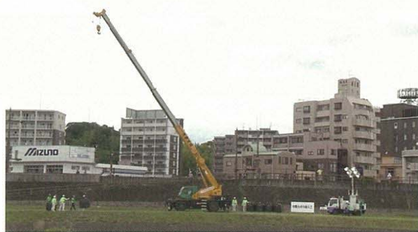
●決壊箇所応急復旧 (一社)熊本市建設業協会、 テックフォース、 九州防災エキスパート会
