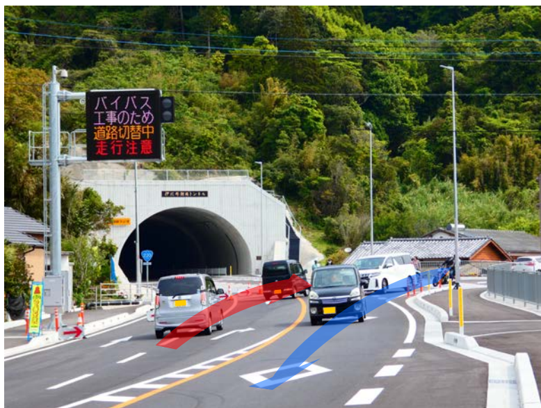
▲開通前(日南市側)
