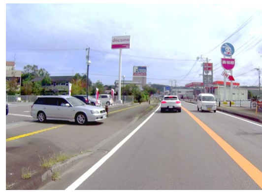
沿道施設への出入り車両も多く後続車を阻害
