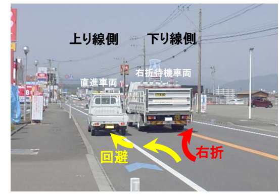
路肩の拡幅整備による追突事故の防止対策
