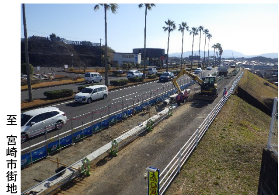
現在の歩道内施工状況 (令和3年12月撮影)
