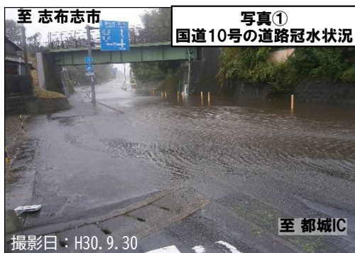
▲ 大雨による冠水状況
