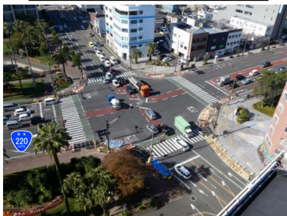
交差点改良前写真(R3.11.29撮影)
