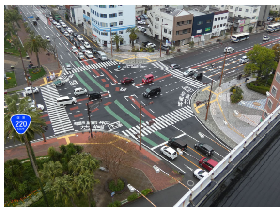
交差点改良後写真(R4.3.28撮影)
