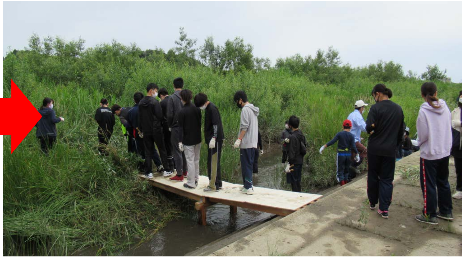
仮橋完成後の様子
