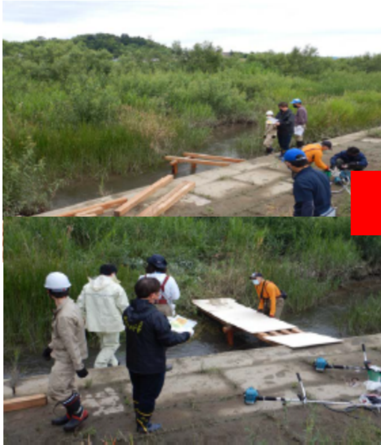
滞筋を渡るための仮橋を設営
