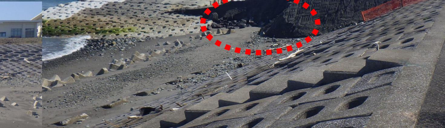
砂浜を回復させるため、突堤周辺に川砂利等の養浜を実施しています。波により海中に土砂を供給するものです。そのため、波の影響で崩落の恐れがありますので、周辺を立ち入り禁止区域としています。規制区域には、絶対入らないでください。
