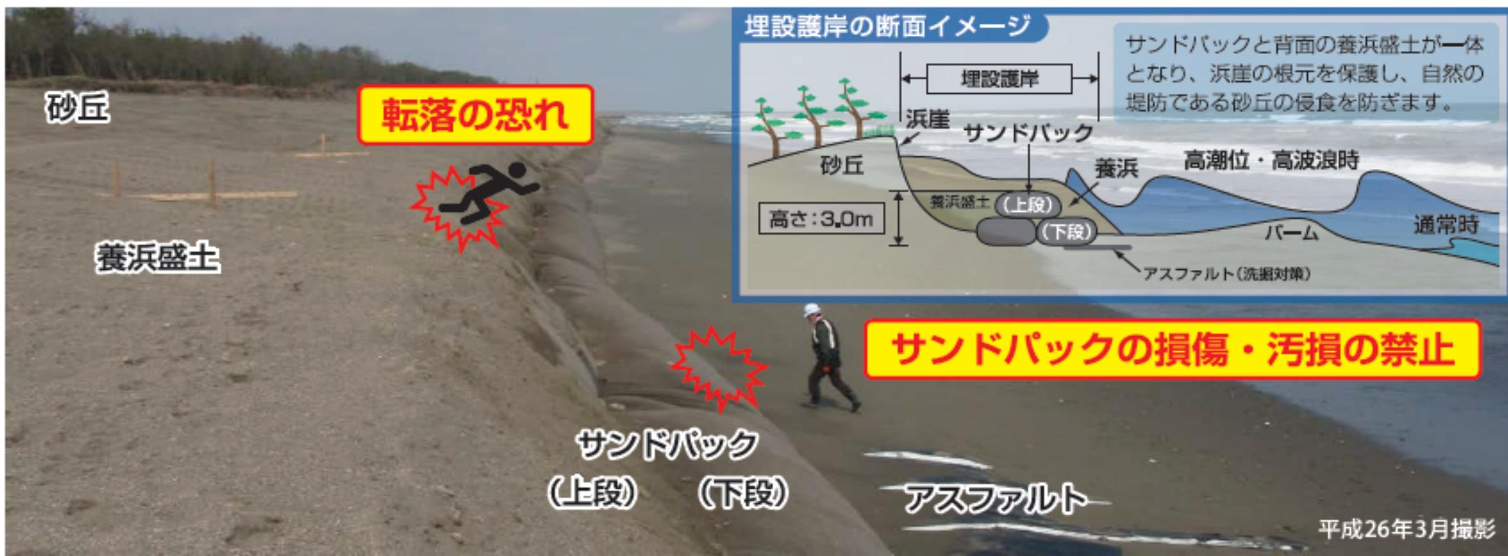
サンドパックは丈夫な合成繊維でできていますが、先のとがったもので刺したり、鋭利な刃物で切ったり、たき火・花火・タバコの吸い殻等の火種を近づけると、サンドパックが損傷し、サンドパックや背後の養浜盛土が崩壊する恐れがあるので、これらの行為をしないでください。
