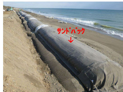
埋設護岸の整備状況写真(サンドバック充填後)
