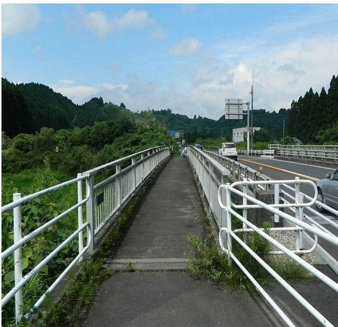
一般国道10号 新狩野橋側道橋 (下り線) L=38.05m
