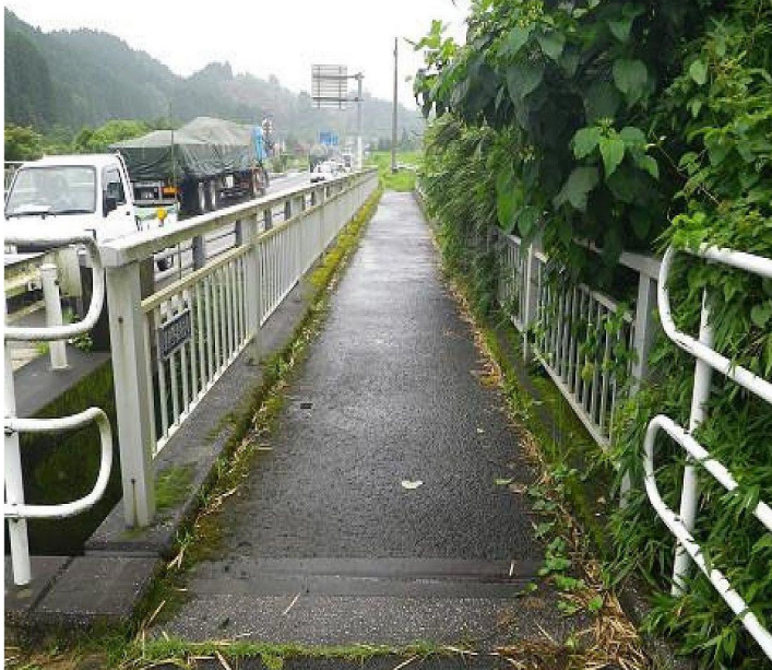
一般国道10号 新狩野橋側道橋 (上り線) L=38.05m
