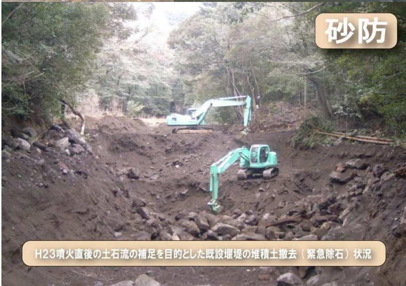
H23噴火直後の土石流の補足を目的とした既設堰堤の堆積土撤去（緊急除石）状況
