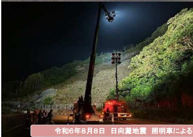
令和6年8月8日 日向灘地震 照明車による夜間作業支援・ロボQSによる落石除去作業
