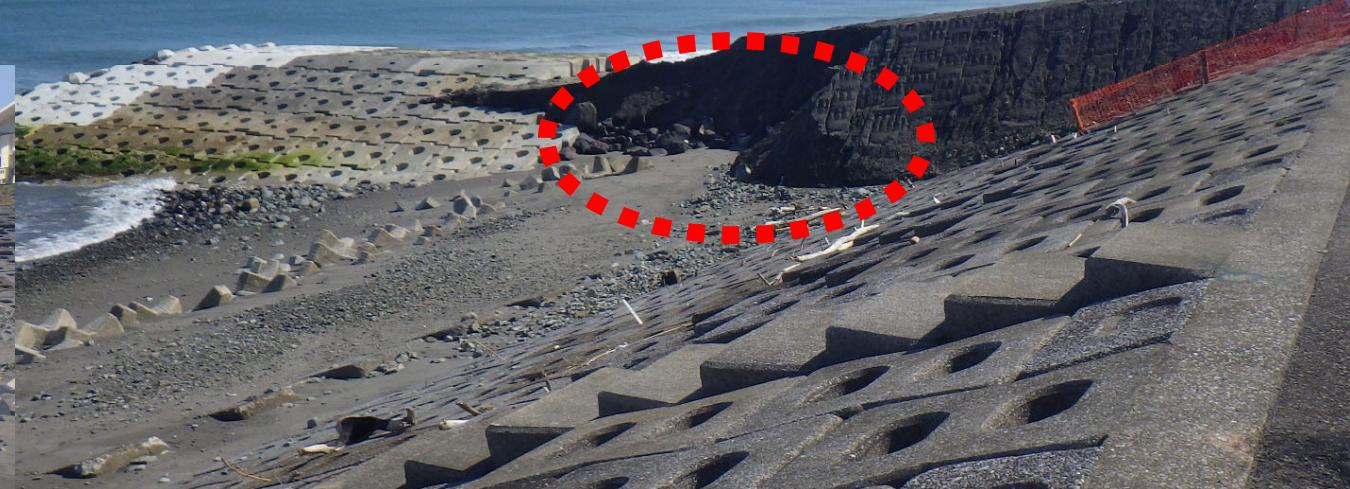
砂浜を回復させるため、突堤周辺に川砂利等の養浜を実施しています。波により海中に土砂を供給するものです。そのため、波の影響で崩落の恐れがありますので、周辺を立ち入り禁止区域としています。規制区域には、絶対入らないでください。
