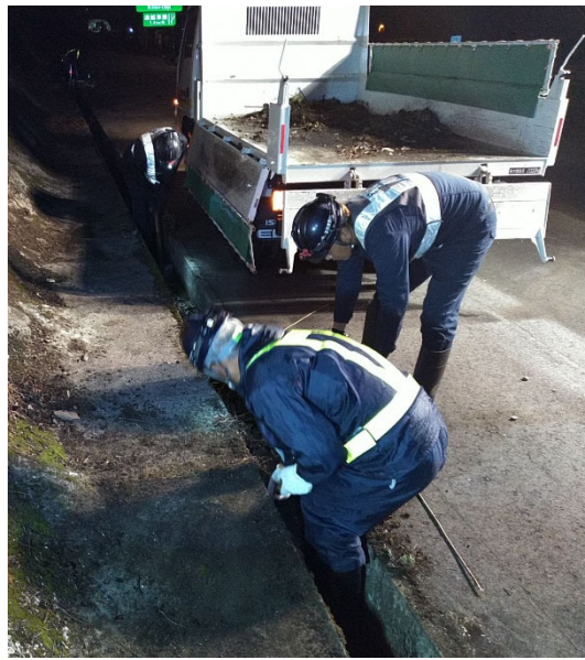
＜排水構造物清掃＞
