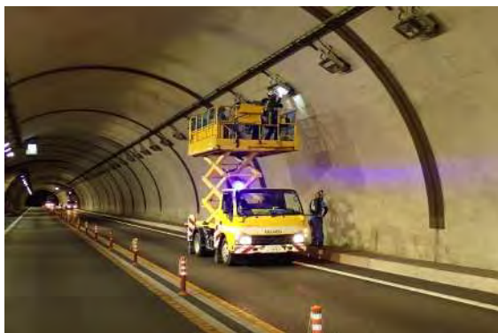
＜トンネル照明点検作業＞
