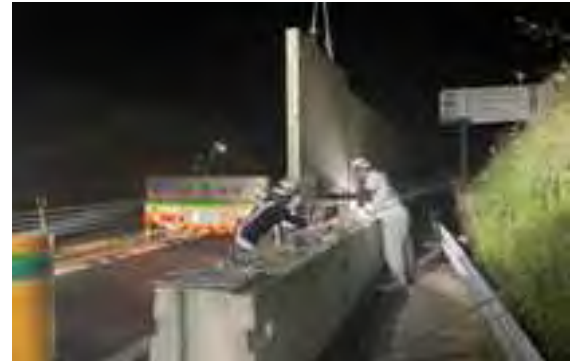
＜バリアウォール移設作業＞
