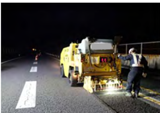
＜舗装補修工事＞
