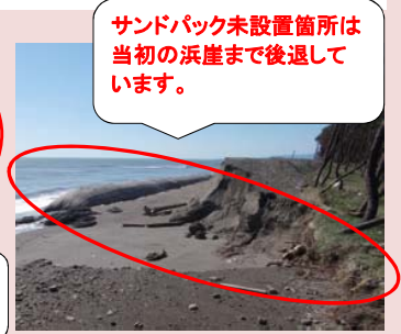
養浜はほぼ流出しましたが、サンドバックにより浜崖は守られています。
