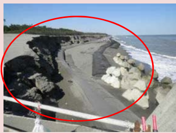
養浜はほぼ流出しましたが、サンドバックにより浜崖は守られています。
