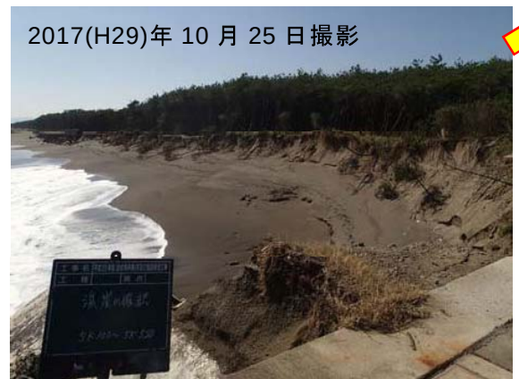
写真 動物園東埋設護岸未設置箇所の侵食状況
