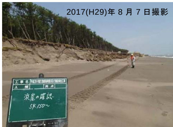
写真 動物園東埋設護岸未設置箇所の侵食状況
