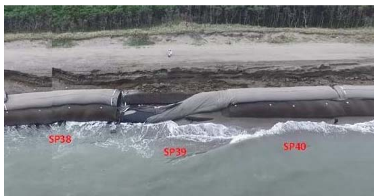
写真 大炊田 SP39 変状写真（2017(H29)年 10 月 24 日ドローンによる撮影）
