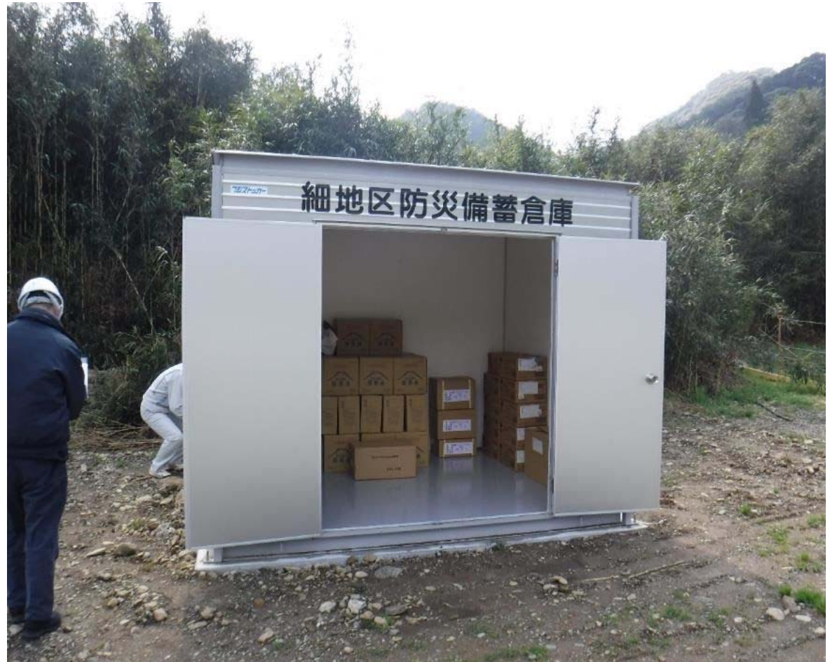
H30年度 山本地区（細地区）に設置の防災備蓄倉庫
